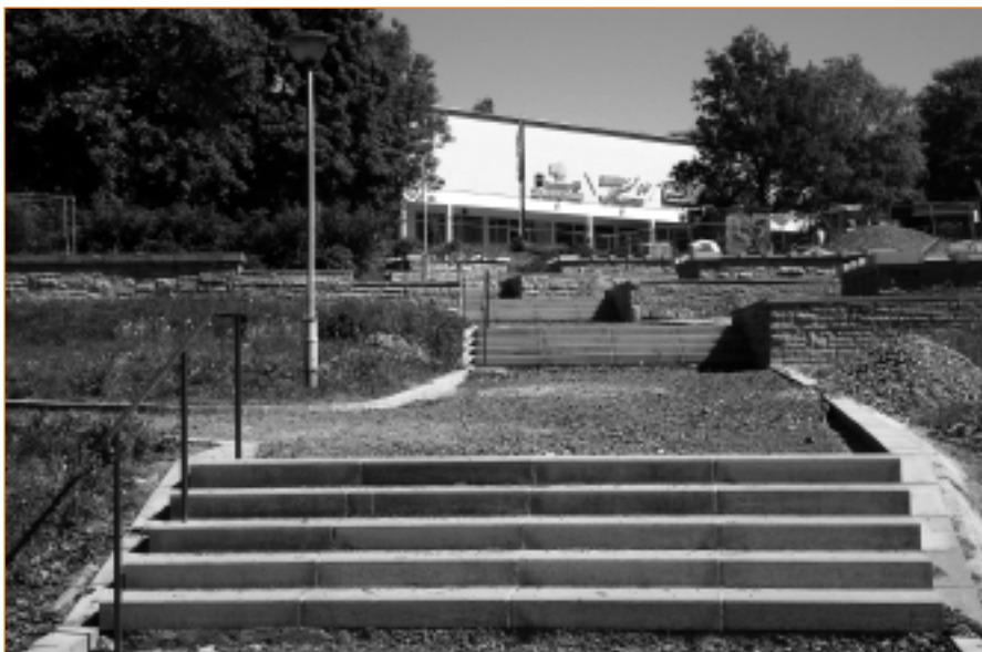
Im April wurden die letzten Stufen gesetzt und die beiden letzten Kaskadenbecken saniert.
