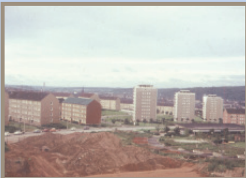
Foto: Frau Zurawski Baugrube "Grüne Mulde" 1970
