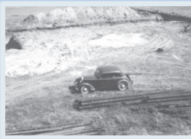
Foto: Frau Dreiling Erich-Weinert-Straße 26-30 ausgeschachtete Aerial
