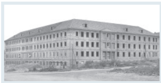
Bergarbeiter-Poliklinik im Rohbau (ca. 1958)
