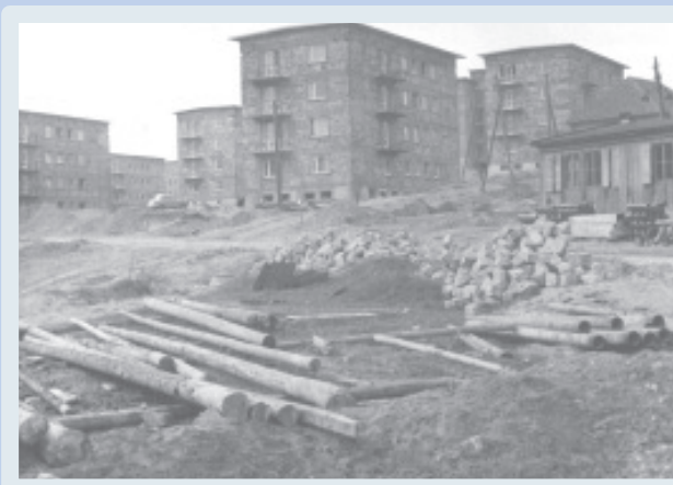
Foto: Herr Renschin Bauabschnitt Erich-Mühsam-Straße
