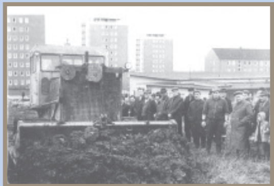
Foto: Stadtarchiv Baubeginn der Grünanlage "Grüne Mulde"
